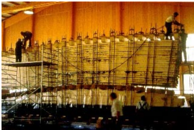
Fig. 5 Prestressing formwork of bridge in Wernau / Neckar (D)
