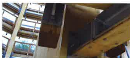
Die Unterflansche der Doppel-T-Profile wurden unterseitig über eine 20 mm dicke Brettlamelle ausreichend geschützt.
