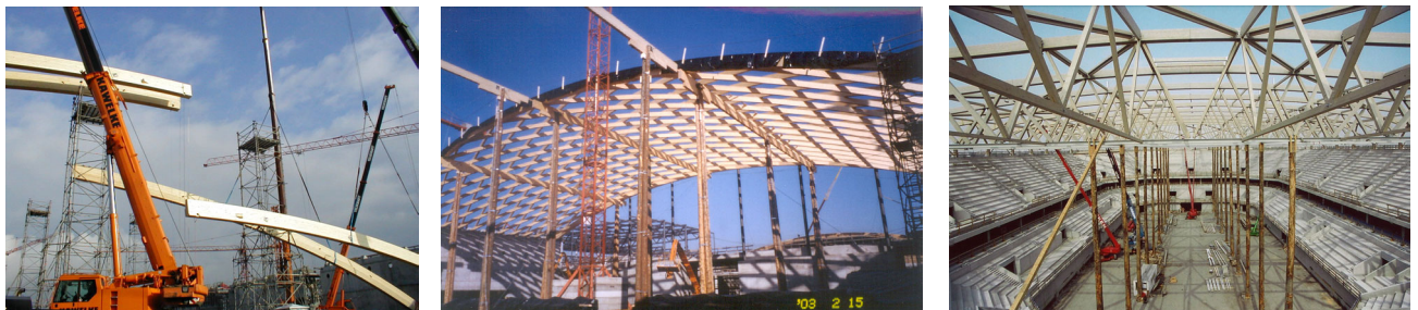
Abb. 8 Montage der Dachkonstruktionen a) Bodenbinder (Balken) Standardhallen NMK b) Lamellenkonstruktion Mehrzweckhalle NMK c) Räumliche Konstruktion SAP-Arena Mannheim
