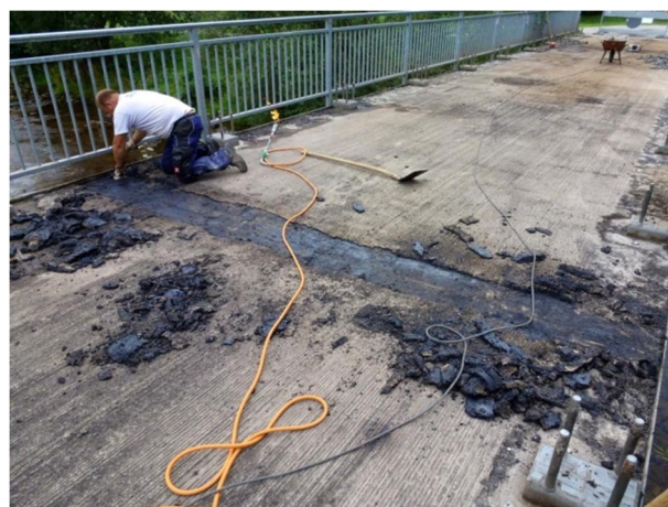
Abbildung 4: Straßenbrücke „Sieh Dich Für“, Baiersbronn-Mitteltal (D) – Rissbildungen vor der Sanierung (links); örtliche Entfernung Schutzschicht (rechts)
