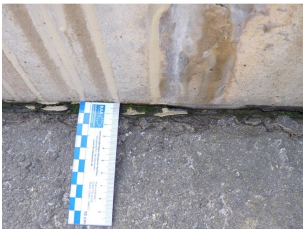
Abbildung 5: links: Straßenbrücke Ruderting (D) mit Rissbildungen Bitumenverguss; rechts: Straßenbrücke Schwarzach-Hengersberg (D) – Befestigung Kappen
