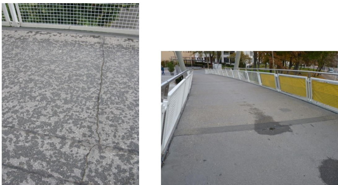
Abbildung 3: Pylonbrücke Ansbach (D) – vor (links) und nach (rechts) der Sanierung
