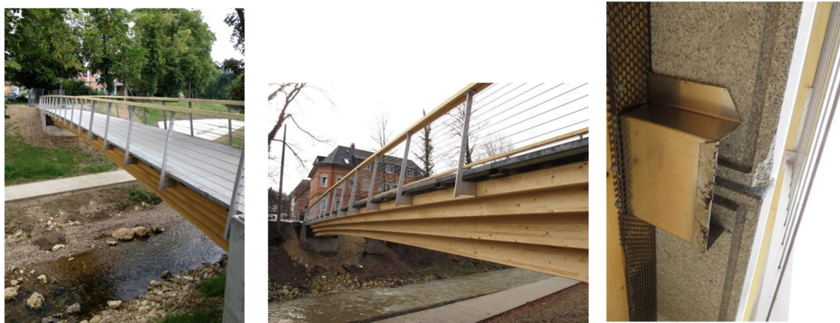
Abbildung 6: Schillersteg über den Josefsbach in Schwäbisch Gmünd - Details Granitbelag (D)
