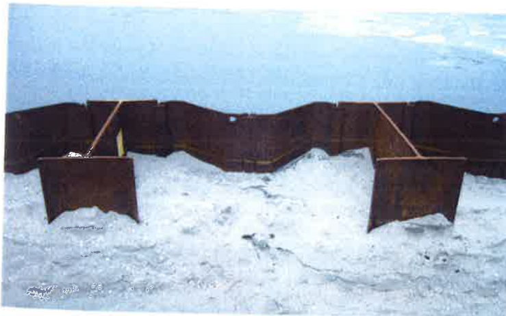
Abb. 1: Segment einer Stahlspundwand
