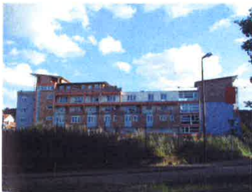
Abb. 1: Wohnhaus Block 9 in Tübingen
