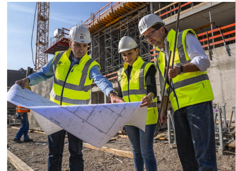
OB PLANUNGSPHASE ODER BAUÜBERWACHUNG: Die Bauingenieure setzen Architektenentwürfe vor Ort um.
