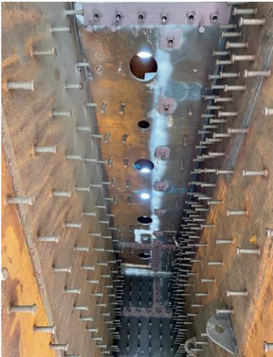
3 Später ausbetonierte Kammer in der Kontaktzone von Stahlüberbau und Widerlager
