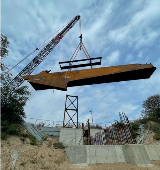
9 Einheben des ersten Stahlteils über das Widerlager
