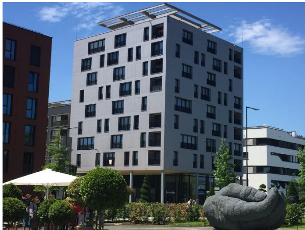
Holz-Hochhaus SKAIO BUGA Heilbronn (D)
