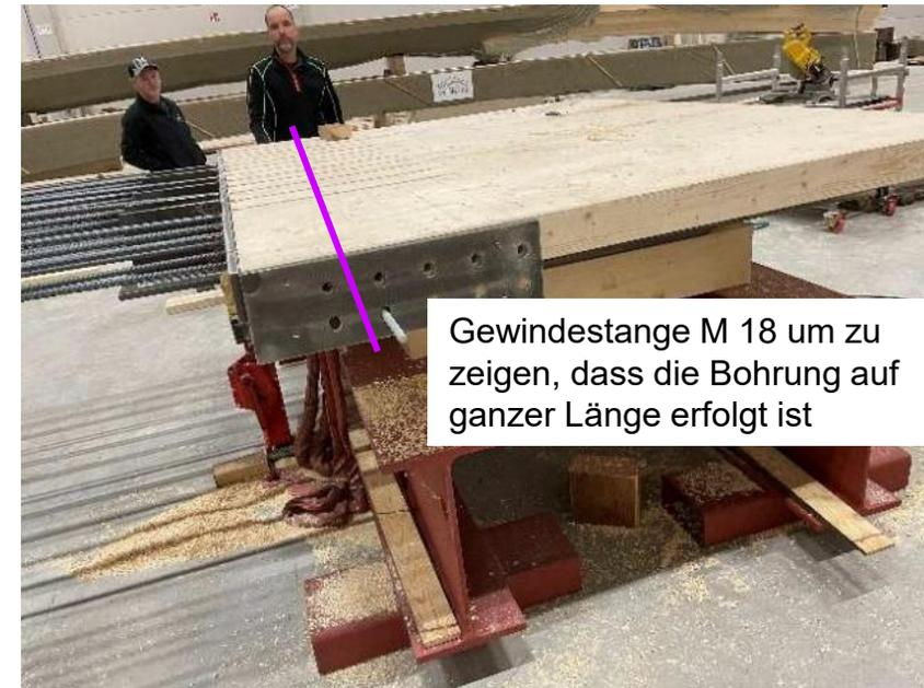
Gewindestange M 18 um zu zeigen, dass die Bohrung auf ganzer Länge erfolgt ist
