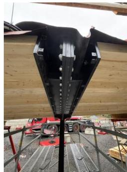
Gussasphalt mit darunter liegendem Dichtungssystem mit Haftschicht (Bauart 1 Variante 1 nach ZTV-ING 6-4) auf aufgeständerter Stahlrippenplatte (Gehbelag; unterlüftet), diffusionsoffene Unterspannbahn auf BSH-Blockträger insbesondere zu Transport- und Montagezwecken
