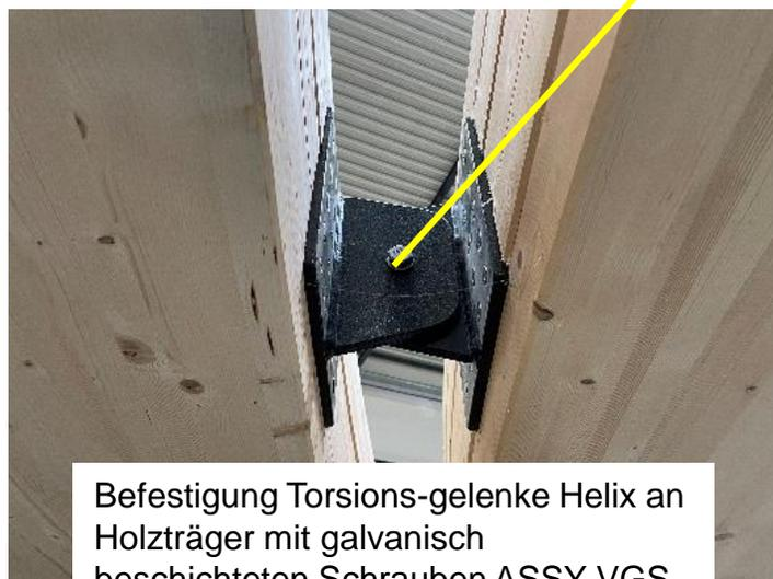
Befestigung Torsions-gelenke Helix an Holzträger mit galvanisch beschichteten Schrauben ASSY VGS Ø12x200mm SK Korrosionsklasse C3 nach EN ISO 12944-2
