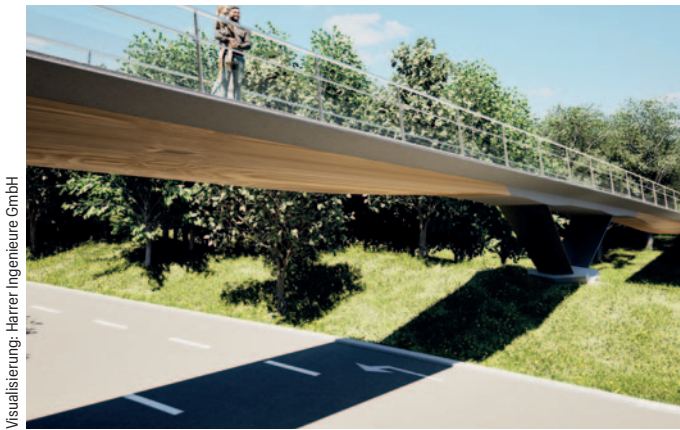
Abb. 1: Holz-Carbonbeton-Verbundbrücke in Stuttgart in der Entwurfsphase
