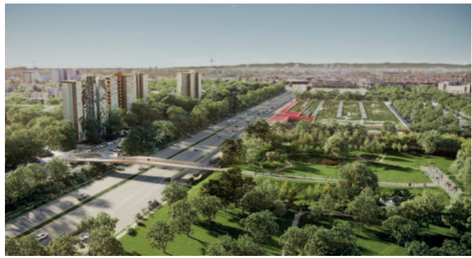
Abb. 6: Visualisierung des Franklin-Stegs mit Hauptspann über die B38 (rechts) mit Spindel/Helix (Rampe links)
