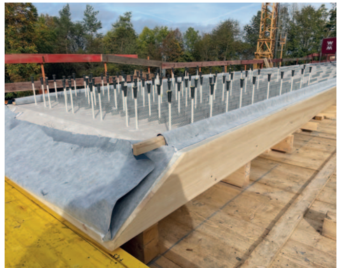
Abb. 4: Holzquerschnitt mit Aufhängebewehrung und HBV-Schubverbindern
